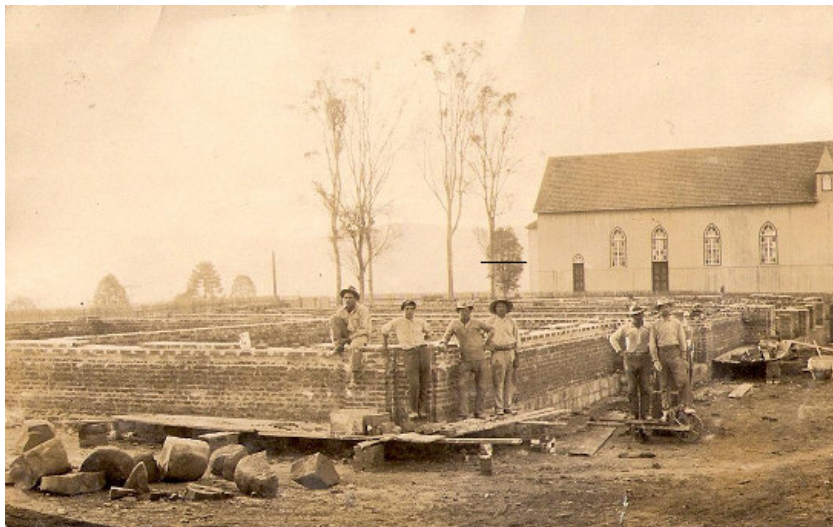
Trabalhadores na construção do prédio de alvenaria do Colégio Nossa Senhora das Graças 35
